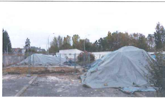
Sécurisation, balisage de la fouille F1 et zones de stockage des terres
