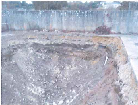
Talutage des bords de la fouille F1
