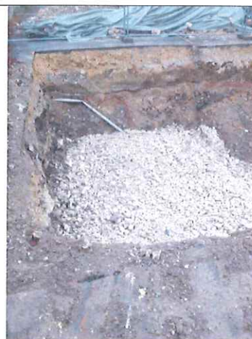
Remblaiement de la fouille F1 avec les matériaux d'apport sains de type calcaire 40/60
