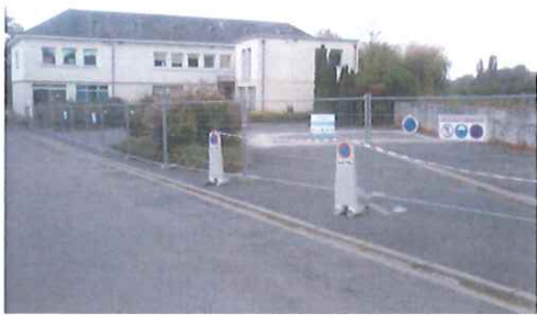
Barriérage de l'accès au site et affichage de chantier
