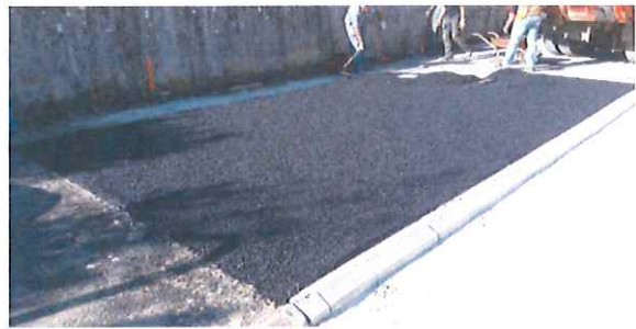
Mise en place de l'enrobé
