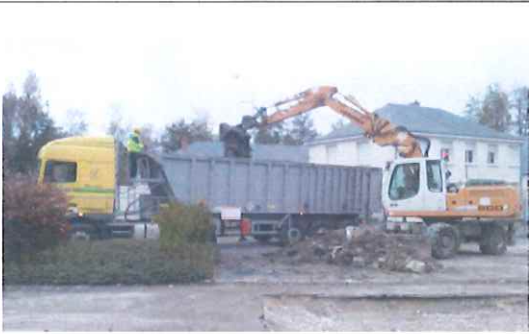
Chargement et évacuation des terres impactées
