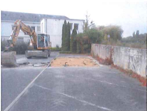
Décroûtage de l'enrobé
