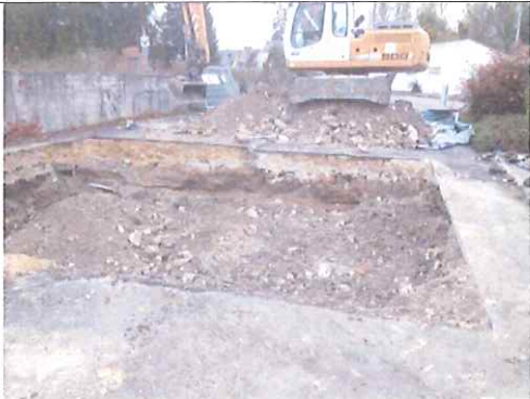
Remblaiement de la fouille F1 avec les terres peu ou non polluées
