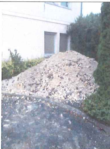
Zone de stockage de la couche de forme réutilisée
