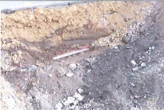
Découverte d'un fourreau électrique non identifié lors des DICT
