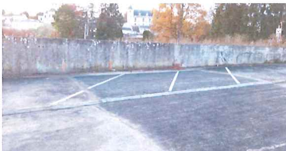
Traçage des places de stationnement
