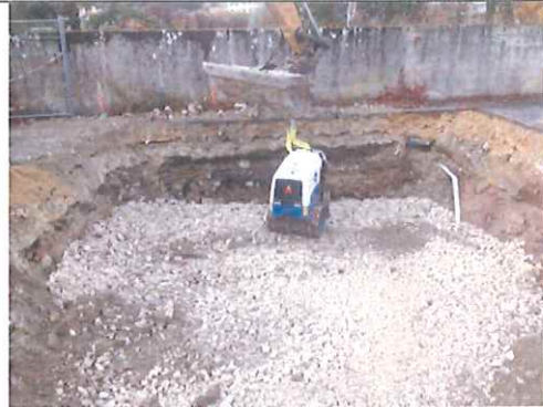
Compactage des matériaux d'apport
