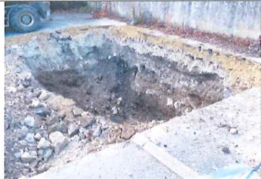
Terrassement de la première moitié de la fouille F1 (Côté mur)
